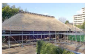
2016 茅葺き屋根の葺き替え完了
