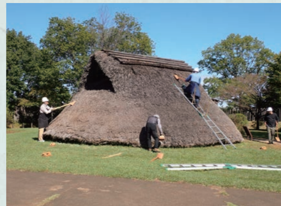
かやぶき屋根プロジェクトによる 竪穴住居の修繕
