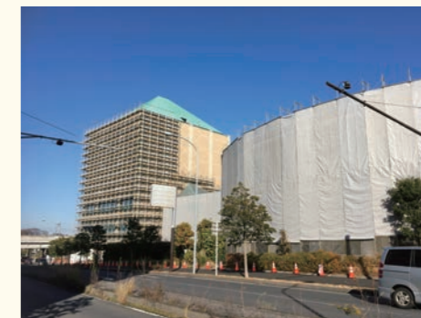
工事中外観 (南側からの様子)
