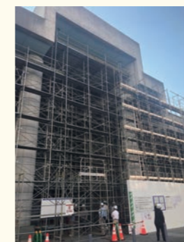
足場が組まれていく様子 (正面玄関)
