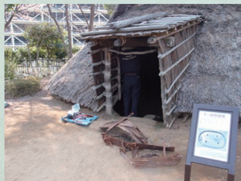
竪穴住居Y80の破損(記録的暴風)
